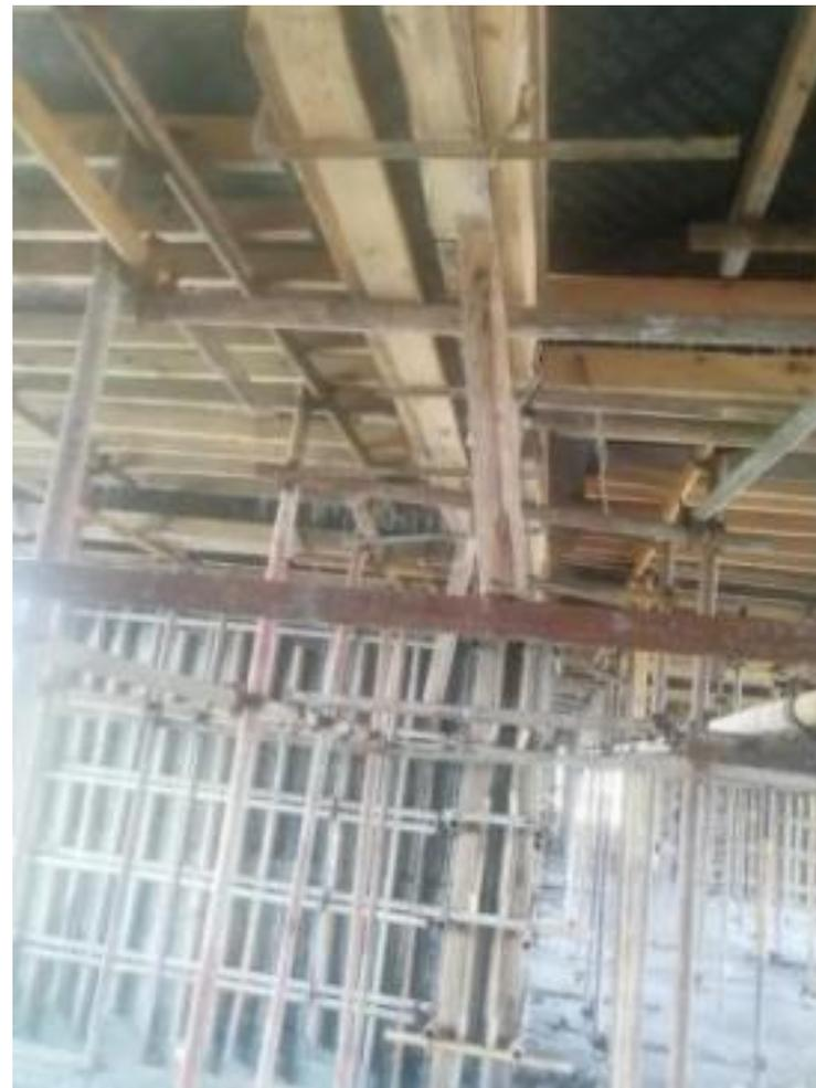
《建筑施工扣件式钢管脚手架安全技术标准》T/CECS 699-2020：构造二节点满堂脚手架：节点处受力水平杆与立杆扣接，其垂直下方水平杆与立杆扣接，且扣件顶紧上方扣件的满堂脚手架，宜用于安全等级Ⅱ级的支撑系统，也可用于作业脚手架。用于作业脚手架时，应按作业脚手架规定的荷载取值计算。
